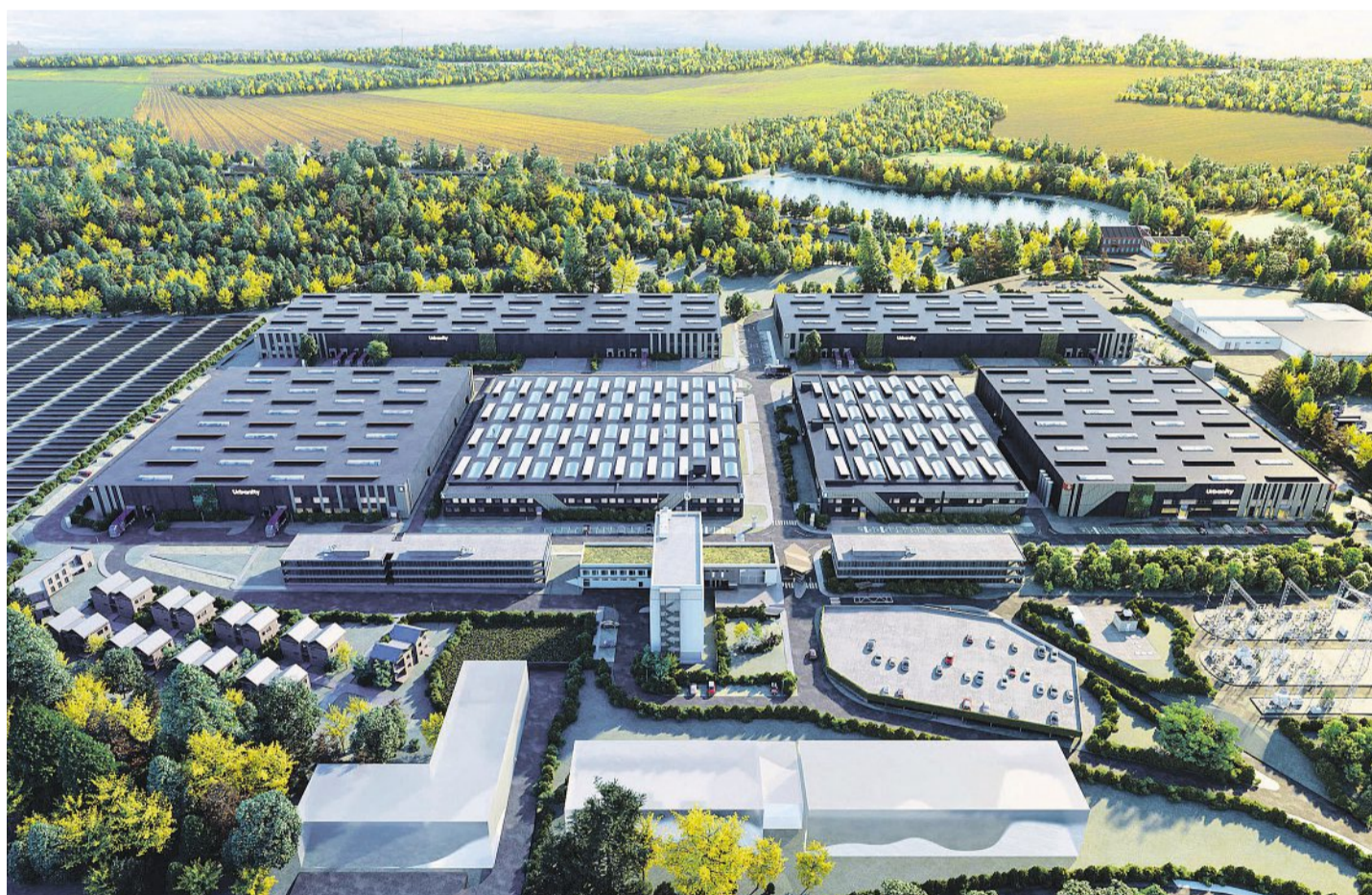
Průmyslový areál nové generace V Tachově roste výrobní kampus, který slibuje nadstandardní občanskou i technickou vybavenost. Týká se třeba i snadné dostupnosti hromadnou dopravou, na kole a pěšky. Foto: Urbanity
