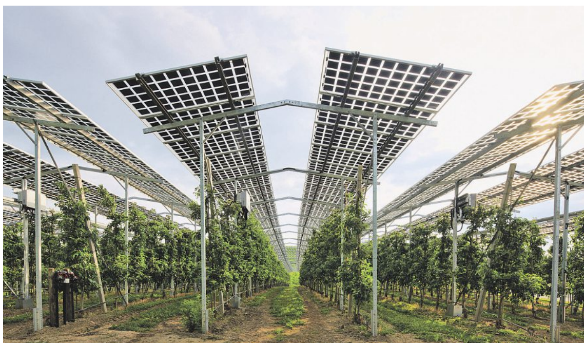
Fotovoltaická elektrárna nad jabloněmi v ovocném statku Bernhard v Kressbrunnu u Bodamského jezera je součástí projektu zkoumajícího vliv agrovoltaiky na pěstování jádrového a bobulového ovoce. Foto: Fraunhofer ISE
