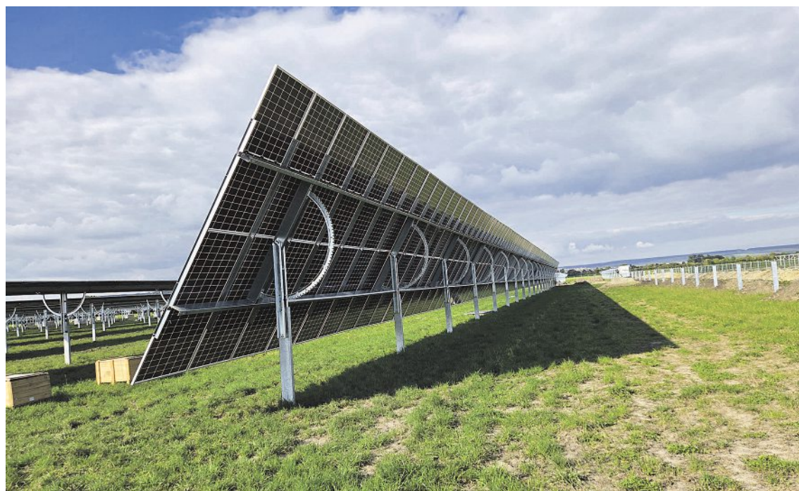
Elektrina a pšenice. Solární panely v Oberdorf am Lech budou zastíňovat zemědělskou půdu o rozloze 28 hektarů. Pod nimi se bude pěstovat pšenice. Projekt realizují Greenbuddies pro energetickou společnost MaxSolar. Foto: Greenbuddies
