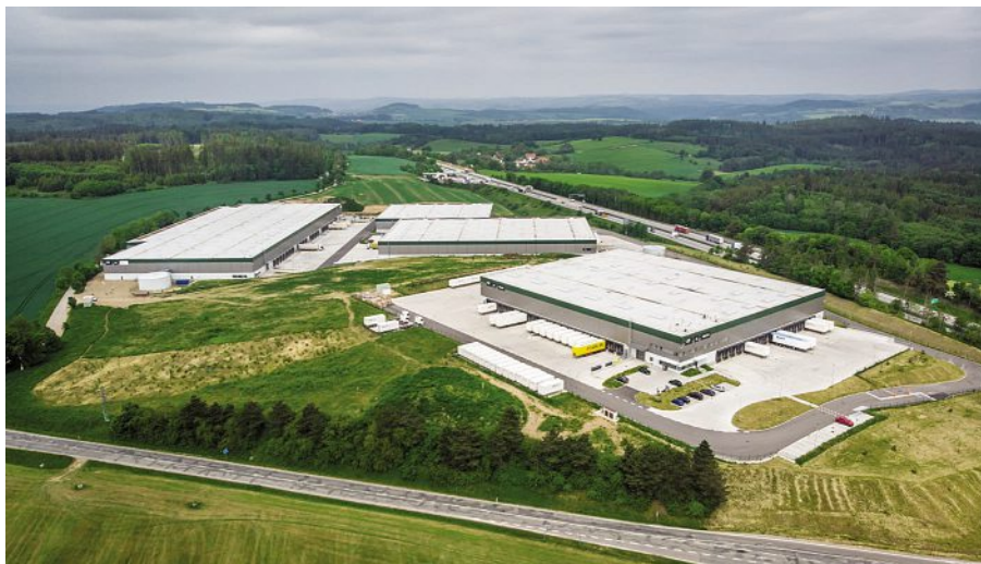
Čerstvě dokončený logistický areál Sázava Logistics Park skupiny UDI Group
