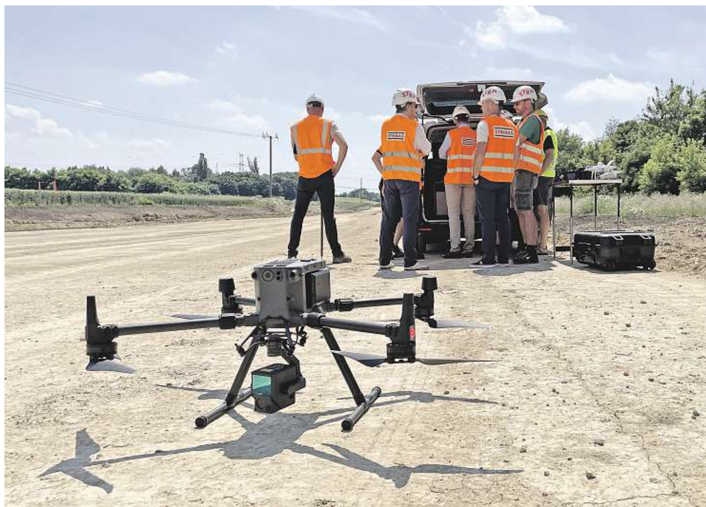
Drony na stavbách sbírají data například pro modelování terénu a kontrolu skutečného stavu stavby nebo pro výpočty odtěžených či nasypaných objemů větších rozsahů.
