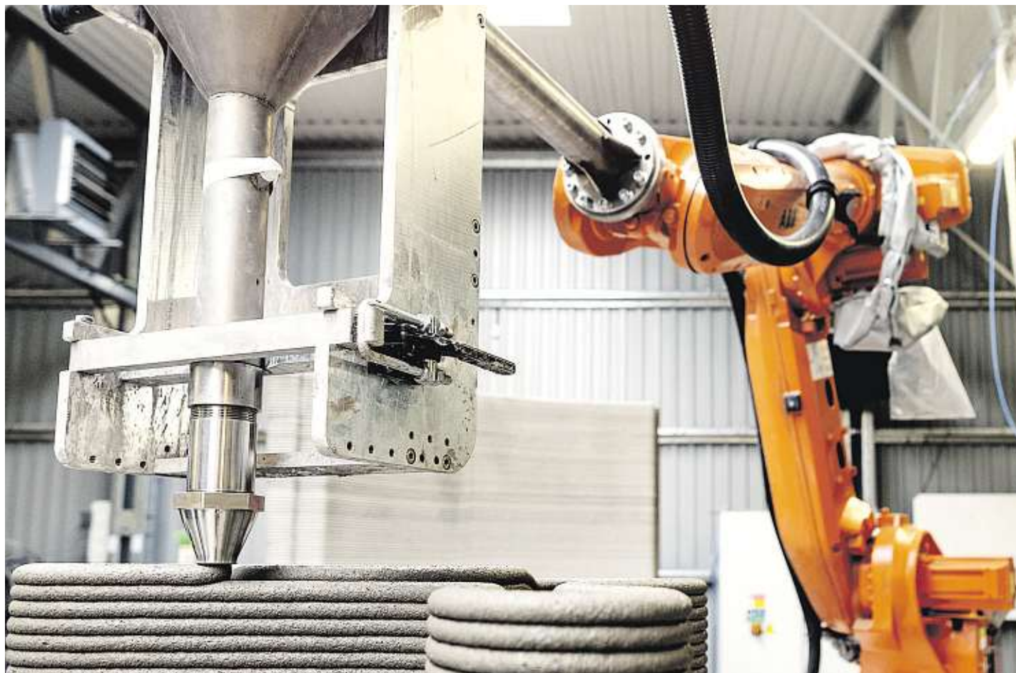
Roboty pomáhají s výrobou prefabrikovaných dílů Pro 3D tisk menších dílů z betonu se používají polární roboty, které se otáčejí podle svislé osy kolem dokola a jejich rameno je schopno se zkracovat a prodlužovat. Foto: ICE
