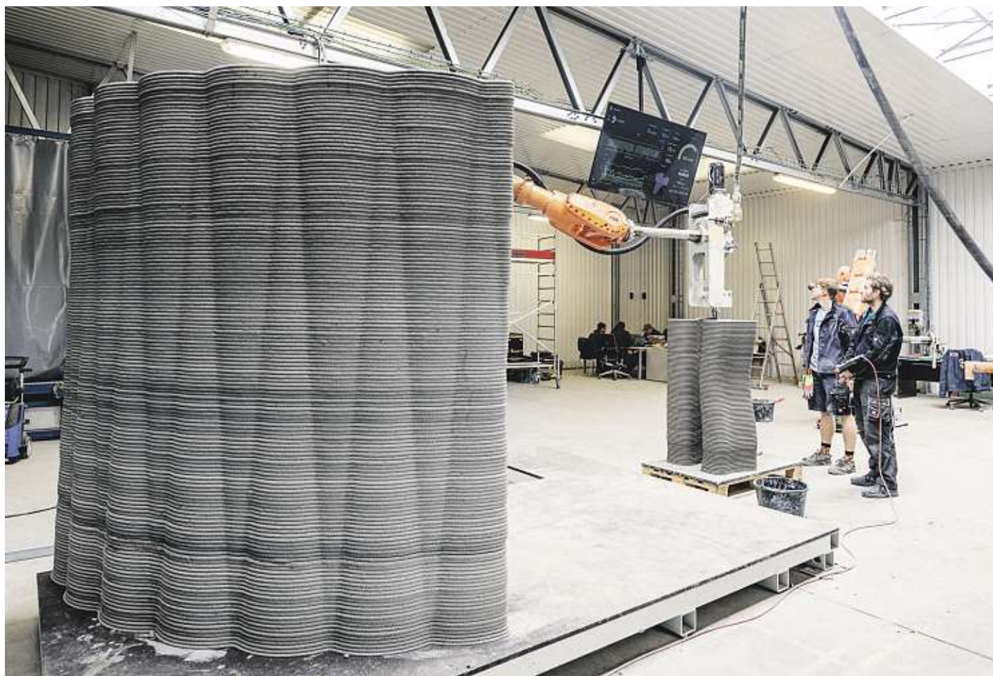
Nový přístup k designu staveb – technologie 3D tisku mění stovky let zažitá stavební postupy. Objekty se mohou hodně přiblížit organickým tvarům, které v přírodě mají specifické vlastnosti. Foto: ICE
