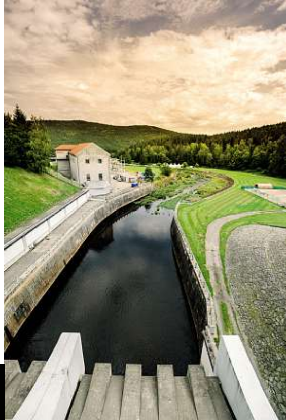
Vodní elektrárna Lipno v jižních Čechách
