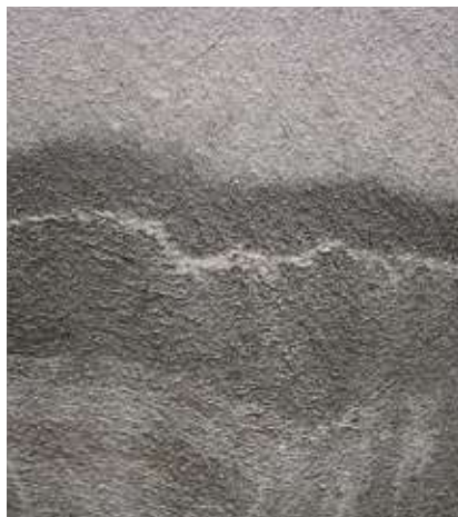
Nahoře: Samoopravná betonová nádrž na čištění odpadních vod
