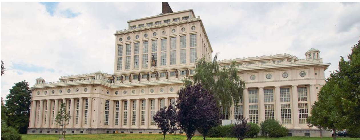
Podolská vodárna je jedním z míst, kde Praha musí řešit dlouhodobou bezpečnost a kvalitu vody.
