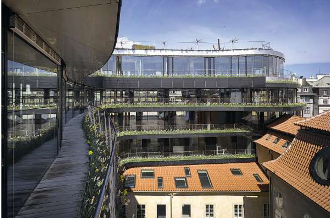
← NÁROŽNÍ ADMINISTRATIVNÍ BUDOVA DRN VYROSTLA NA PRAŽSKÉ NÁRODNÍ TŘIDĚ V MÍSTĚ, KDE DLOUHÁ LÉTA BÝVALO JEN NEVZHLEDNÉ PARKOVIŠTĚ.
