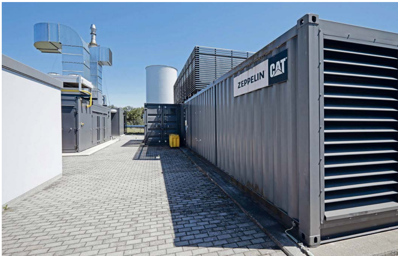
Součástí energetiky budovy jsou dva dieselové agregáty (foto nahoře) a také kogenerační jednotka (foto dole).
