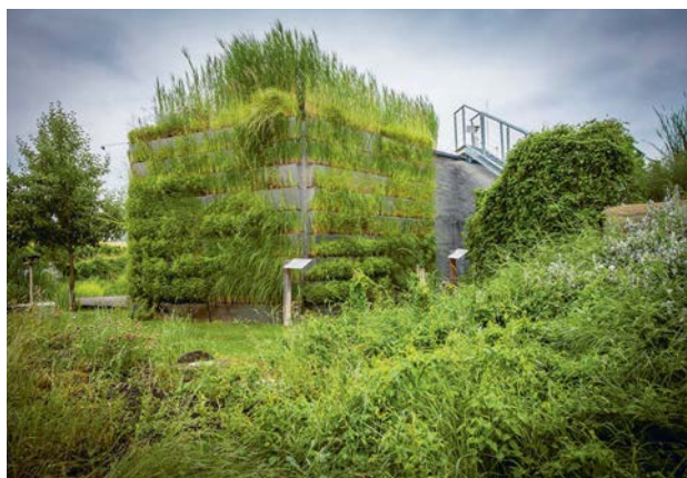
Firma Kořenovky se podílela na návrhu mokřadních střech a fasád a systému recyklace vody v areálu společnosti Liko-S ve Slavkově u Brna, za což získala řadu ocenění.
