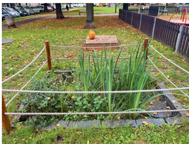
Díky kořenovce na Puškinově náměstí v Praze se neplýtvá pitnou vodou na splachování veřejných toalet. Mokřadní záhon navíc městský prostor v létě ochlazuje a celoročně zdobí.
