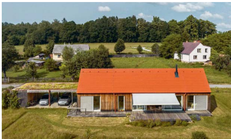
Nahore: Dům ohně a dřeva. Černá část fasády je vyrobena z opalovaných smrkových palubek.
