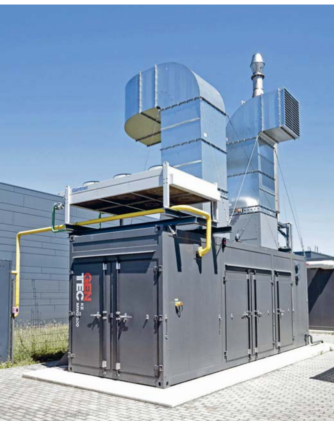
Součástí energetiky budovy jsou dva dieselové agregáty (foto nahoře) a také kogenerační jednotka (foto dole).
