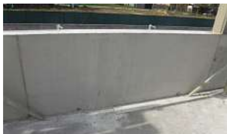
Pohledový beton dobré kvality.
