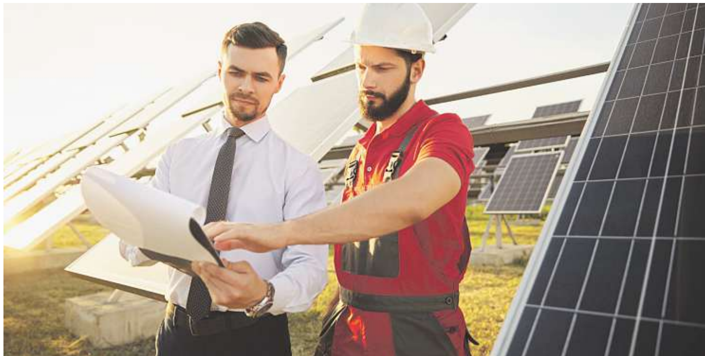
Smlouva a revize. Důležité je minimalizovat všechny komplikace v dobře ošetřené smlouvě. Zároveň nikdy nepřebírat instalaci, která má viditelné nedostatky.
