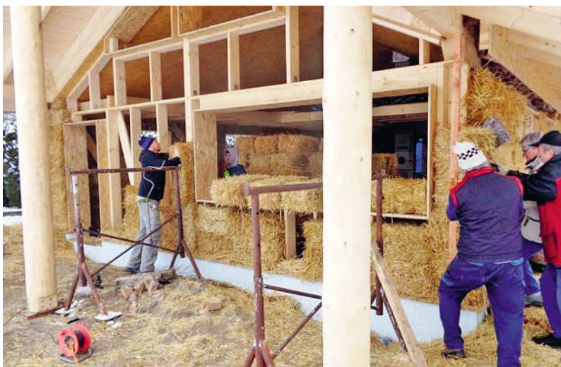
Instalace slaměných balíků do fošinkové dřevěné konstrukce je pracná. Studio Baobab proto vyvinulo systém slaměných panelů.
