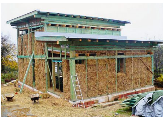
Instalace slaměných balíků do fošinkové dřevěné konstrukce je pracná. Studio Baobab proto vyvinulo systém slaměných panelů.
