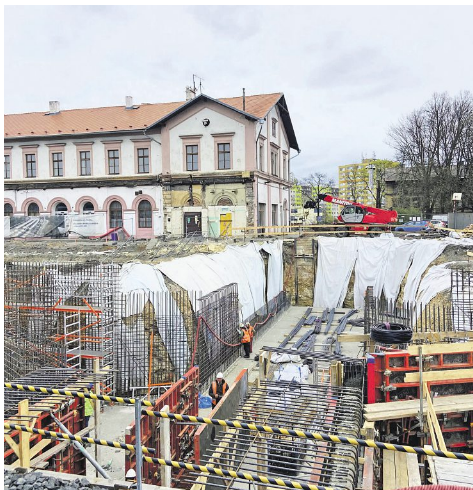
Tvrzení Správy železnic: Kladenské nádraží má i špatné základy. Navzdory tomu budova zatím s přehledem ustála i rozsáhlé stavební práce. Foto: Jan Beránek
