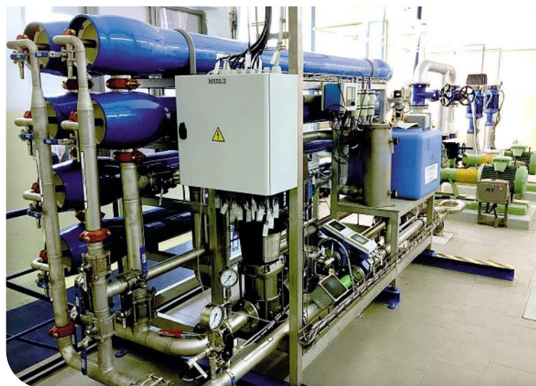
Úprava pitné vody s technologií nanofiltrace, Domašov nad Bystřicí
