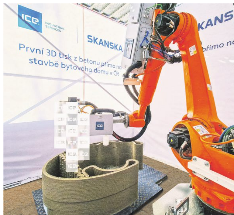
Atypická sanitární místnost. Použitá 3D tiskárna je jedna z největších v Česku. Foto: ICE Industrial Services
