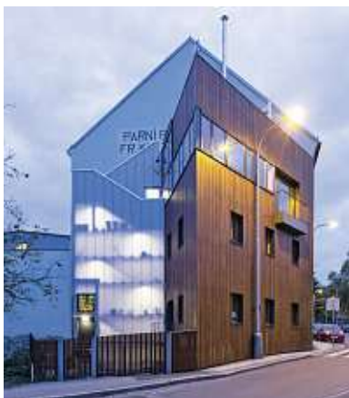
◀ Přestavba rodinného domu R.U.A. (2016) / Praha
