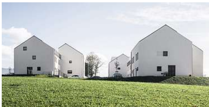
▲ Bytové domy v Rožnově pod Radhoštěm Studio acht (2020)
