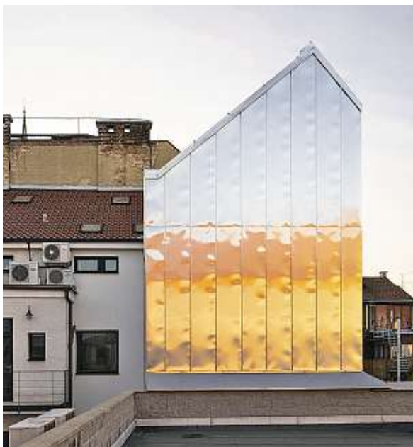
▲ Přístavba kanceláře ve Vysokém Mýtě Prokš Příkryl architekti (2019)
