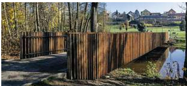
▲ Lávka na Farských humnech Refuel (2020) / Žďár nad Sázavou
