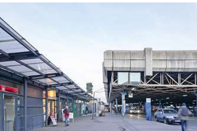
▲ Ústřední autobusové nádraží Zvonařka Chybík + Kristof Architects & Urban Designers (2020) / Brno
