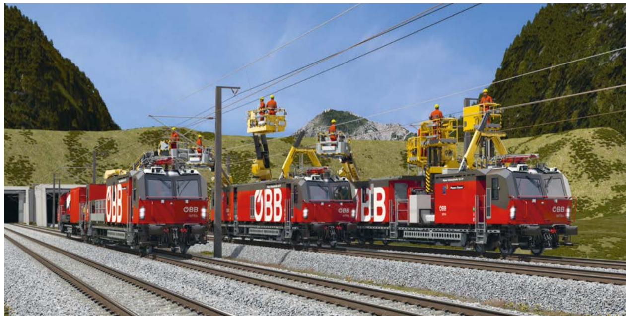
Plasser CatenaryCrafter 15.4 E 3 při práci na trolejovém vedení v rámci nové servisní flotily ÖBB. Speciální pracovní plošiny umožňují bezpečný přístup i do obtížně dostupných míst při údržbě železniční infrastruktury.
