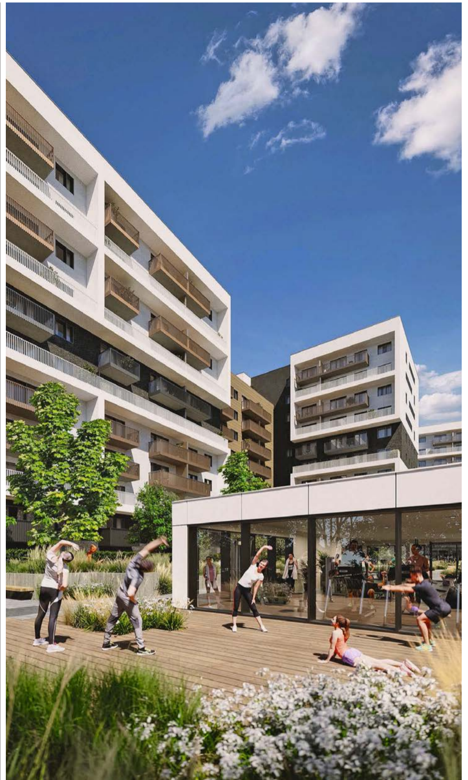
Rezidenční komplex se v současnosti staví s ohledem na větší nároky klientů, kteří od nich očekávají kvalitu pro život i veškeré služby v dosahu. Foto: Daramis
