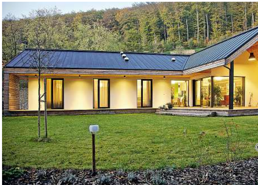
Pasivní dům od toho běžného odlišují technologie a izolace.
