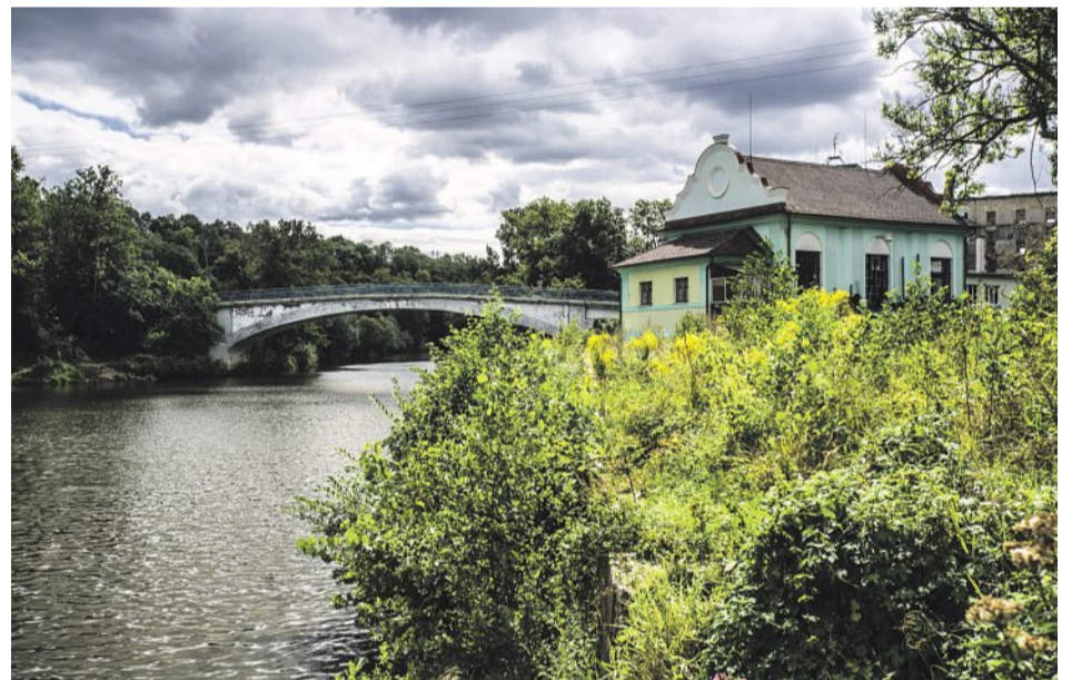
Vodní elektrárna patří rodině Lišků v obci Vinec u Mladé Boleslavi. Funkčních malebných elektráren na českých tocích mnoho nezbylo. Foto: HN – Zbyněk Pecák
