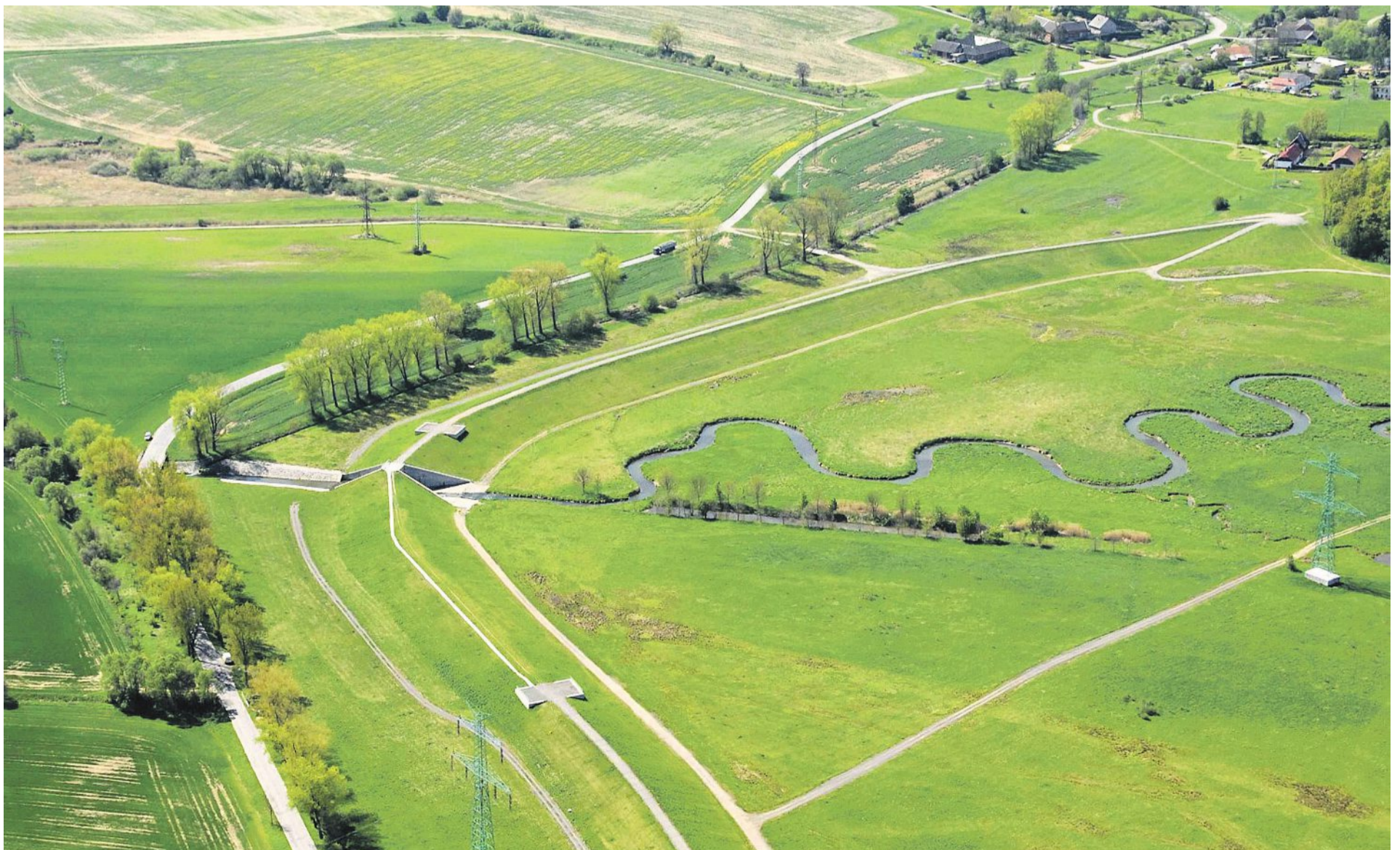
Jednou z alternativ jsou suché a polosuché poldry. Ten v Žichlínku na Moravské Sázavě chrání před povodněmi od roku 2008 a je největším suchým poldrem v Česku. Proti povodním chrání především Litovel a Olomouc, ale i další obce podél toku Moravské Sázavy a Sázavy. Foto: sindlar.cz
