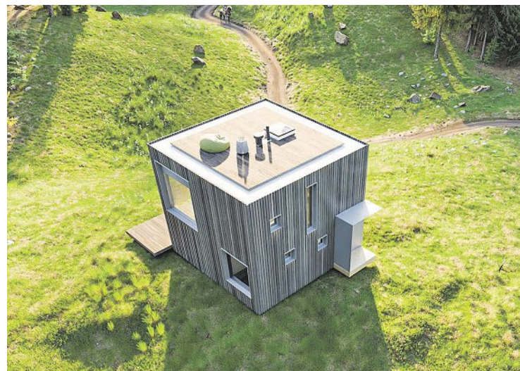
Projekt společnosti Bayaya , inovativní dřevostavby jsou v souladu s přírodou. Foto: Bayaya
