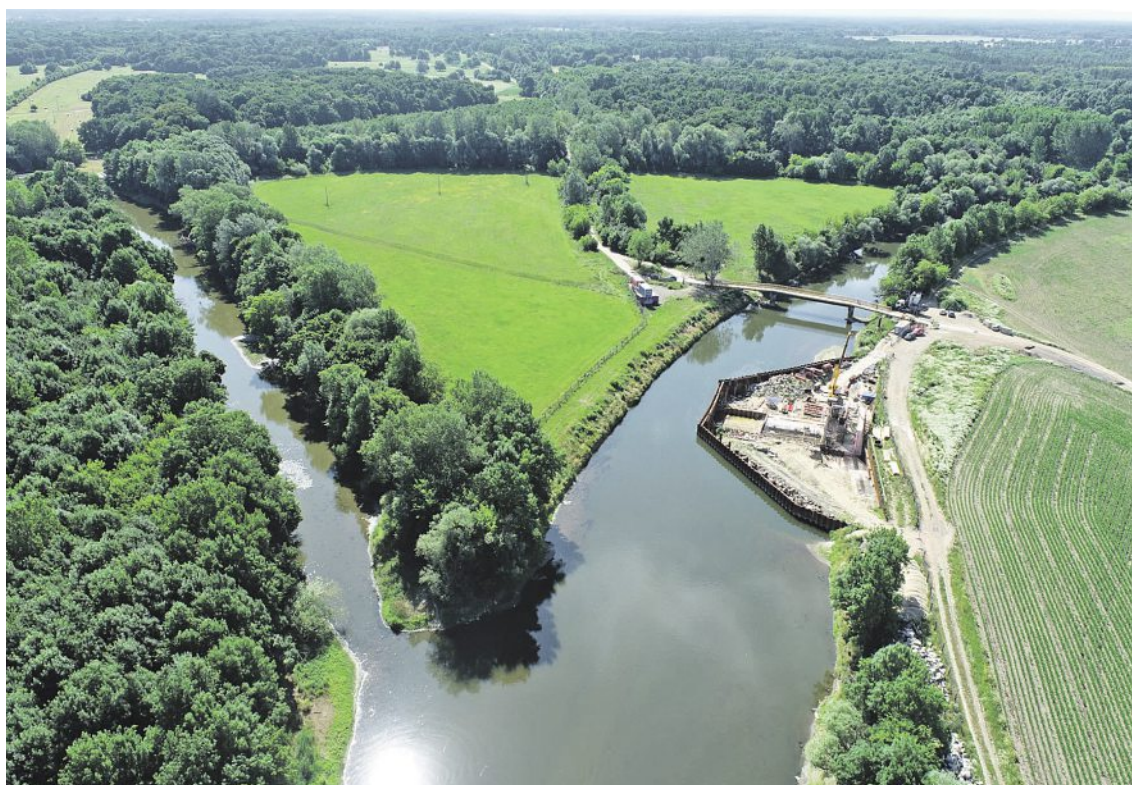
Vláha pro Moravskou Amazonii. U trojmezí Česka, Rakouska a Slovenska vznikne na řece Dyji vzdouvací klapkový jez. Ten pomůže zavodňovat 1600 hektarů lužního lesa nad soutokem Moravy a Dyje.
