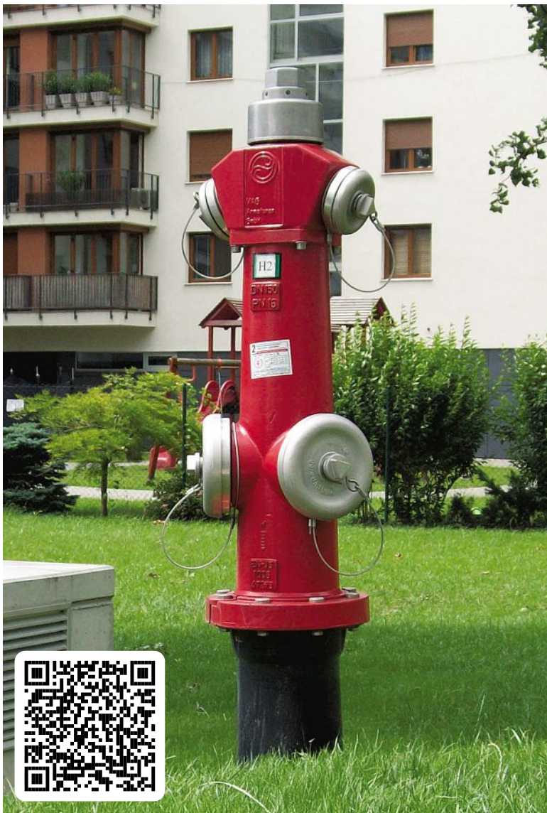
Instalace VAG NOVA 150 Nadzemního hydrantu v bytovém komplexu Eden Park v Bratislavě
