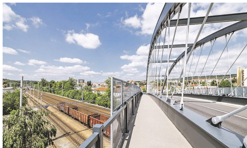
Kompletní dokončení stavby. Předání díla investorovi je naplánováno na červen 2023.
