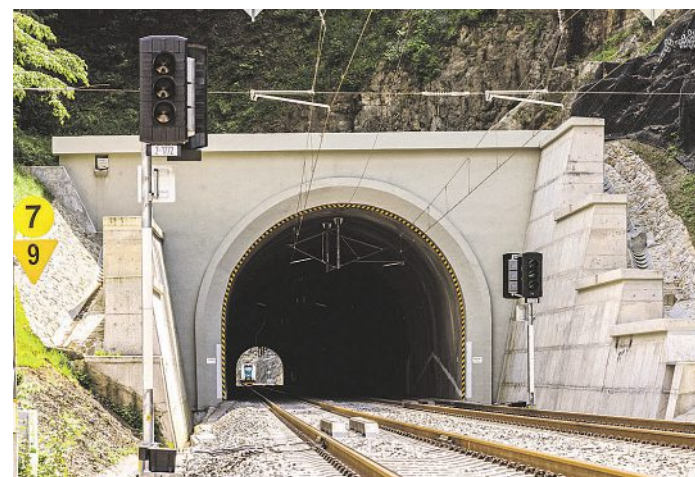
Pět tunelů. Oproti běžné rekonstrukci tunelů výrazně navýšily práce.
