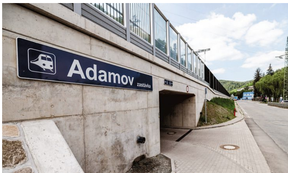
Nejsložitější práce na projektu. Patří mezi ně rekonstrukce mostů a sanace skalních zářezů a svahů.
