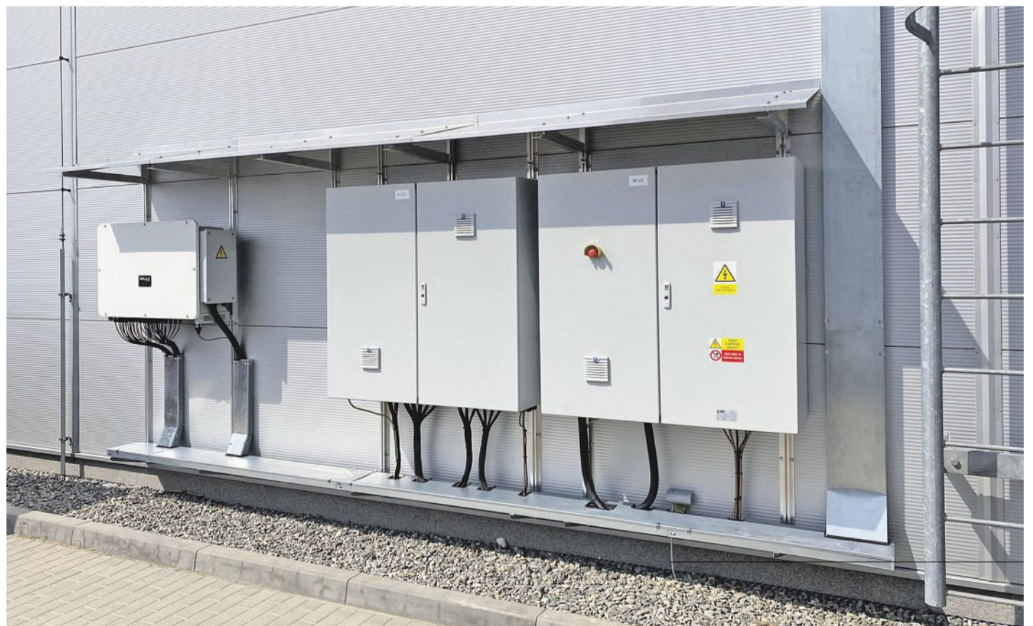
SolaX Pro tuto výrobu byl konkrétně zvolený střídač Solax X3-FTH-100K. Zdroj: Lunek
