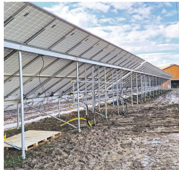
Realizace výstavby pozemní části fotovoltaické elektrárny v Agro Sedlice.
