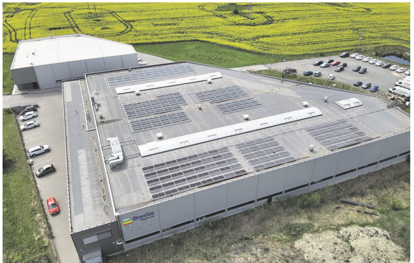
Realizace 100kWp fotovoltaické elektrárny pro společnost v Jihomoravském kraji, která instalovaným výkonem snižuje vlastní spotřebu výrobního a skladovacího areálu. Zdroj: Lunek
