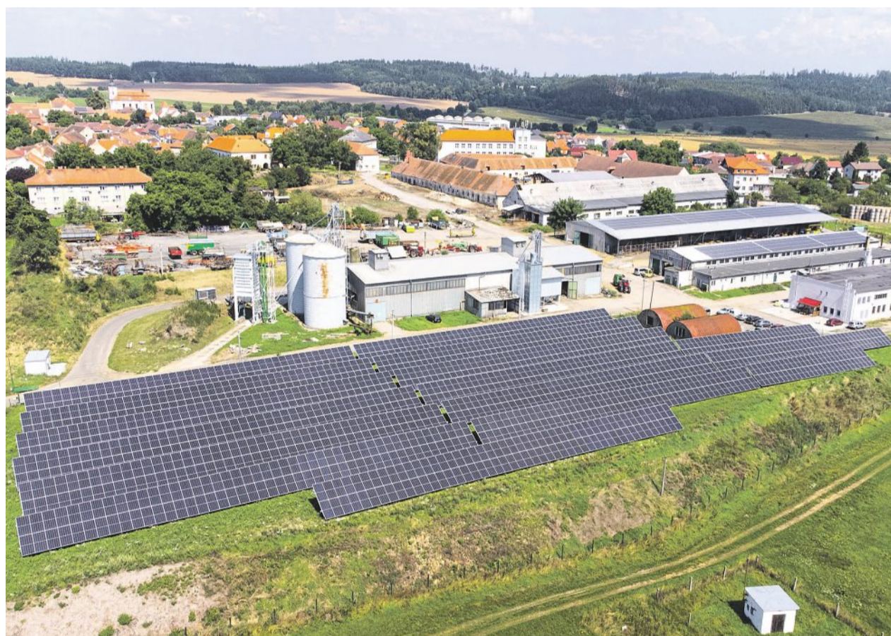
Dokončená fotovoltaická elektrárna zemědělské společnosti AGRO Sedlice.
