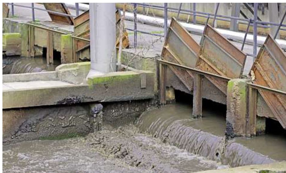
Vyrábí vlastní energii V energicentru (vlevo) se kalový plyn přeměňuje na teplo a elektřinu. (Vpravo nahoře) Jedna z odstavených usazovacích nádrží. (Vpravo dole) Nátok aktivizační směsi bakterií a odpadní vody. Do aktivizační směsi se dává síran železitý, který snižuje koncentraci fosforu. Fosfor by jinak mohl přispívat k tvorbě sinic, které jsou toxické.
