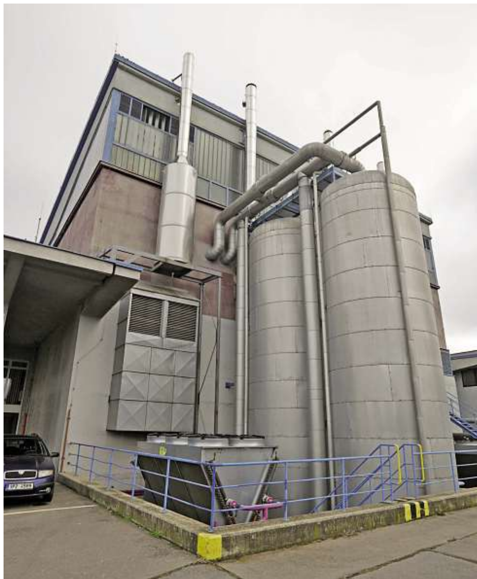
Vyrábí vlastní energii V energicentru (vlevo) se kalový plyn přeměňuje na teplo a elektřinu. (Vpravo nahoře) Jedna z odstavených usazovacích nádrží. (Vpravo dole) Nátok aktivizační směsi bakterií a odpadní vody. Do aktivizační směsi se dává síran železitý, který snižuje koncentraci fosforu. Fosfor by jinak mohl přispívat k tvorbě sinic, které jsou toxické.
